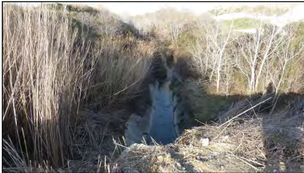
Roubine de l'Étang au Sud-Ouest de la plateforme : cours chenalisé
