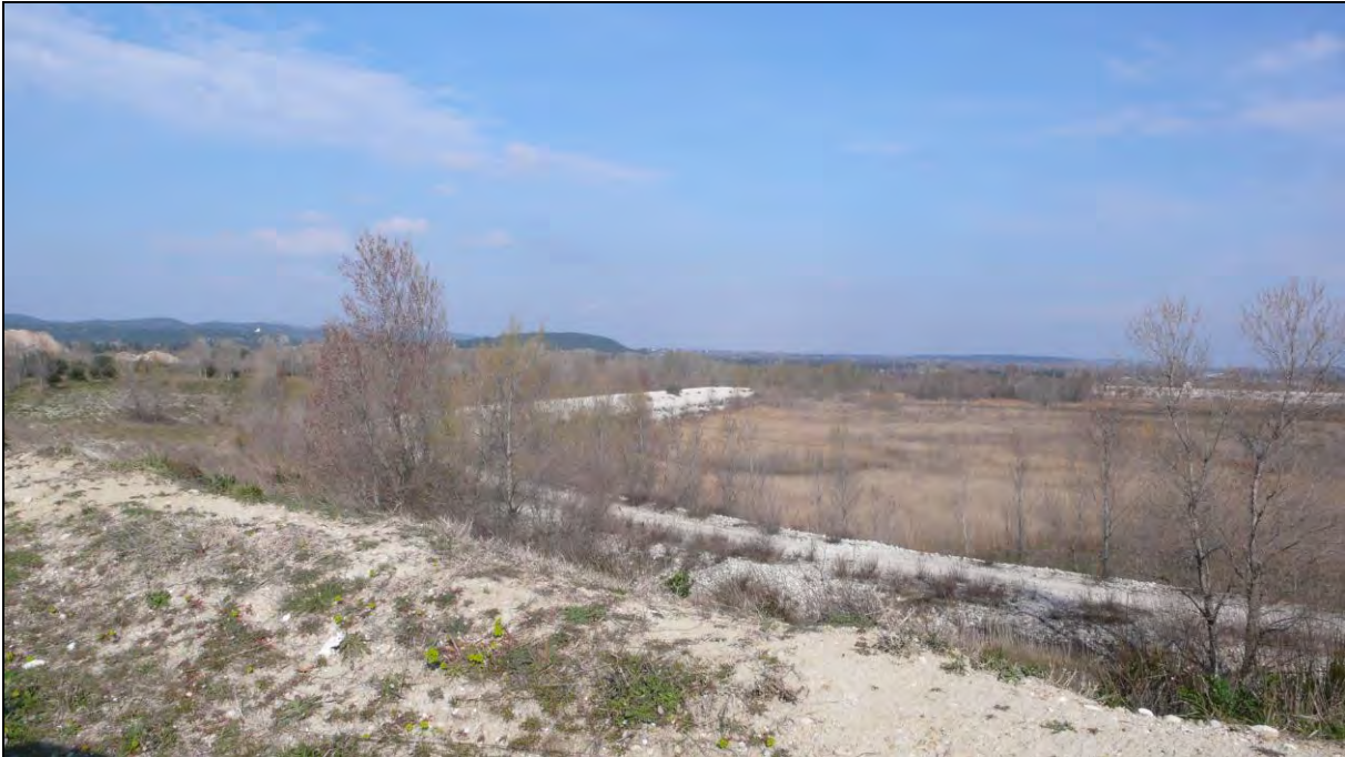
Zone de rétention des eaux du Planas
