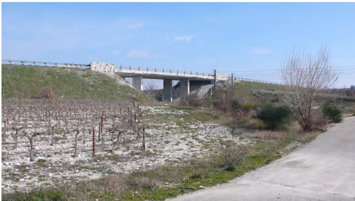
La ligne LGV Lyon-Marseille et franchissement par le pont de la RD26
